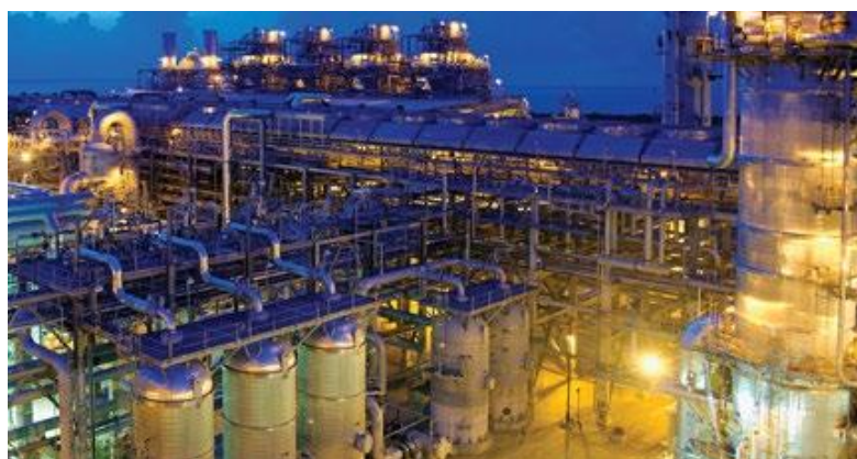
The Darwin LNG plant. (ConocoPhillips)
